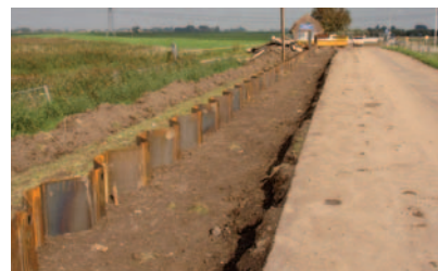
Tracé stalen damwand
