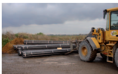
Lossen van de stalen buizen
